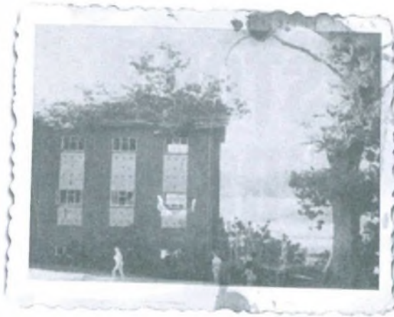
Dach fliegt weg!
